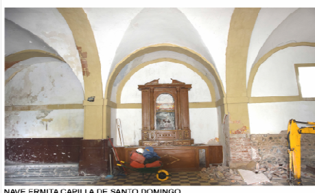
NAVE ERMITA CAPILLA DE SANTO DOMINGO
